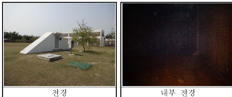
【사진 3.27】 매룡배수지 전경
