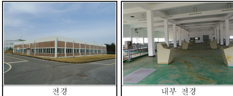
【사진 3.89】 여과지동 전경
