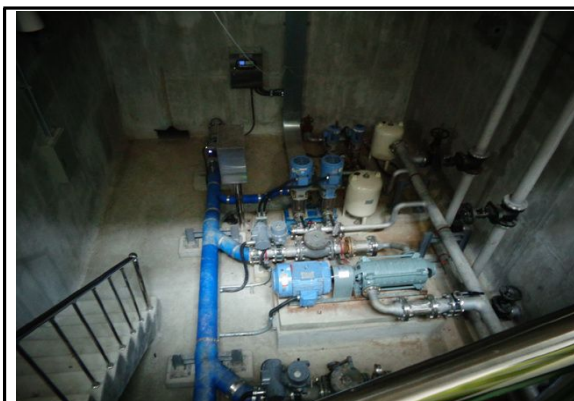
벽체 폭 0.3mm미만 균열
