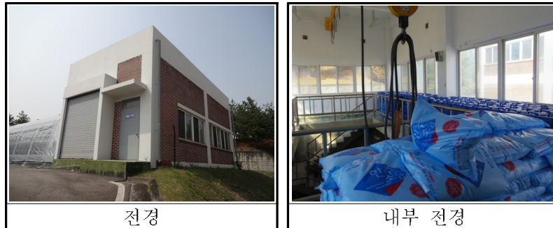
【사진 3.101】 배출수지펌프동 전경
