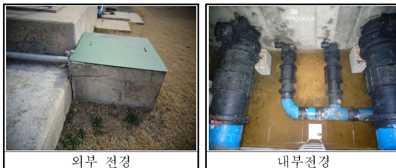
【사진 3.1】 착수정 전경
