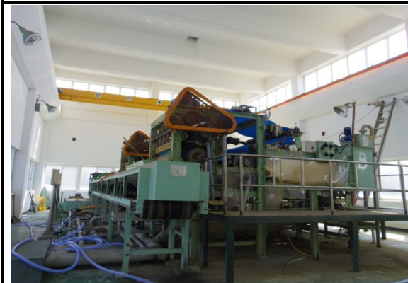
탈수기동 호이스트 상태양호
