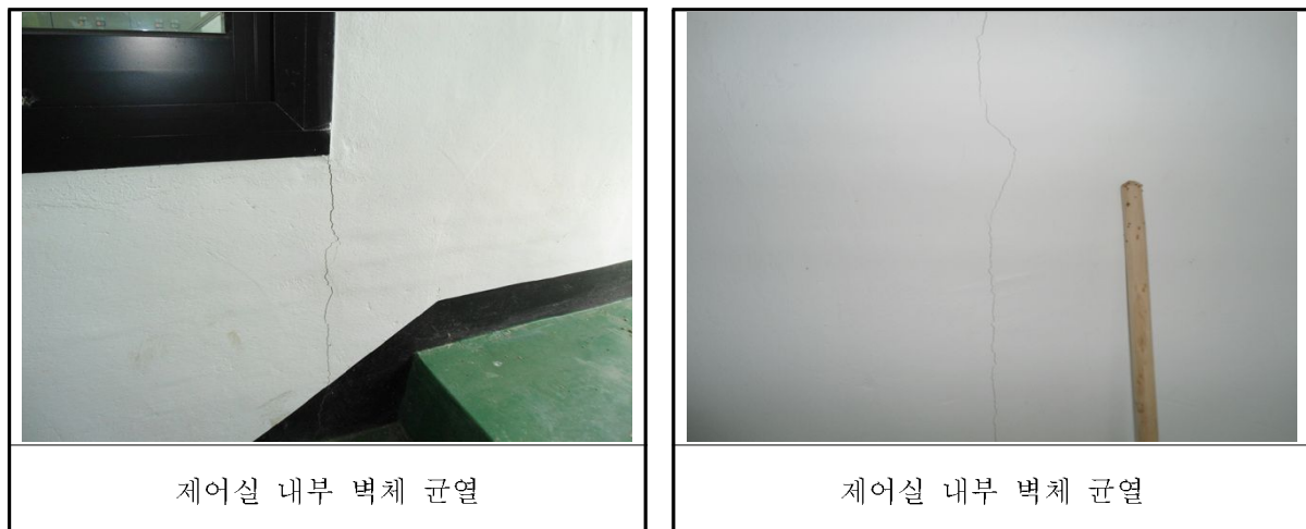
【사진 3.38】 산북배수지 손상현황
